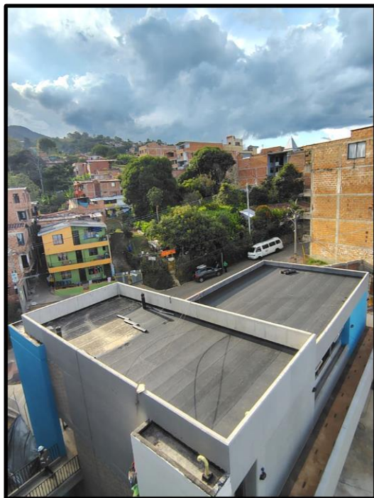
CUBIERTAS CON MANTO IMPERMEABILIZANTE "GRANILLADO"
