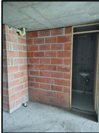
BUITRONES Y MUROS EN MAMPOSTERÍA EN EL INTERIOR DE LOS APARTAMENTOS
