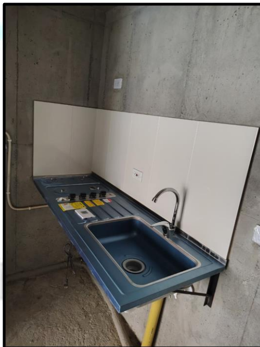
LAVADERO Y CUBIERTA EN ACERO CON SALPICADERO EN ENCHAPE BLANCO
