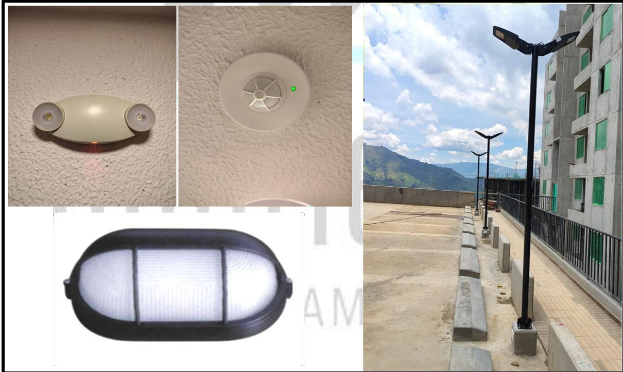
LUMINARIAS Y SENSOR DE MOVIMIENTO
