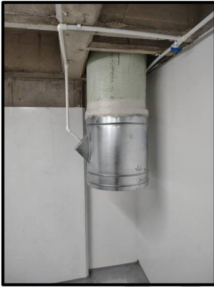
DUCTO, ROCIADOR Y COMPUERTAS
