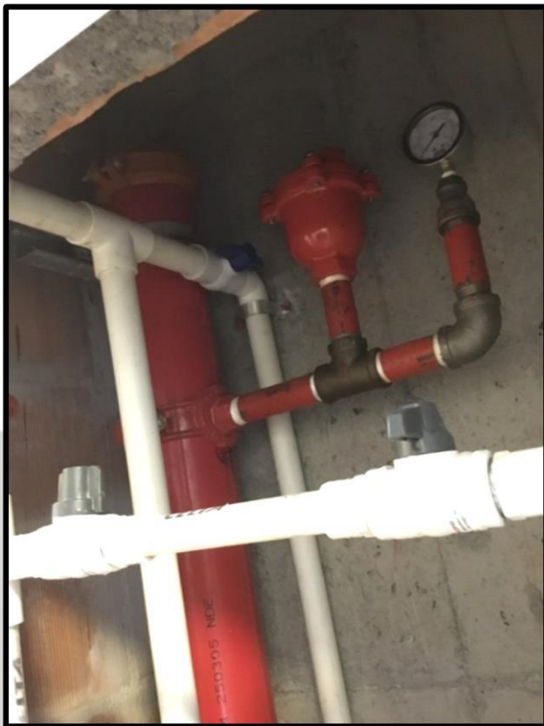
TUBERÍA Y ACCESORIOS RCI
