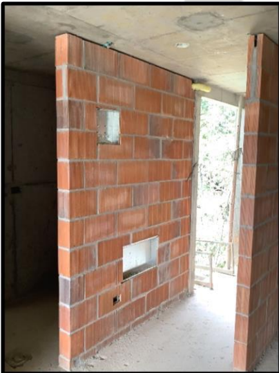
BUITRONES Y MUROS EN MAMPOSTERÍA EN EL INTERIOR DE LOS APARTAMENTOS
