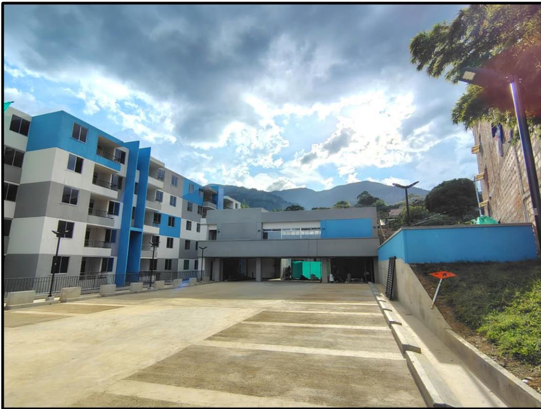
PLATAFORMA DE PARQUEADERO VEHICULAR
