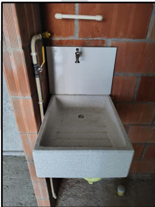
LAVADERO Y CUBIERTA EN ACERO CON SALPICADERO EN ENCHAPE BLANCO
