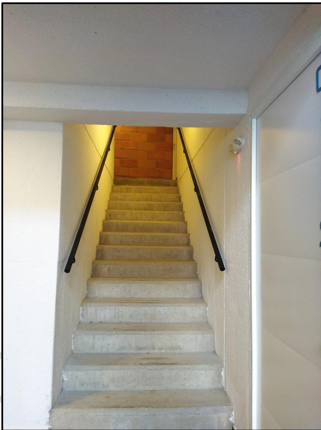
ESCALERAS DE ACCESO PUNTO FIJO PISO 1
