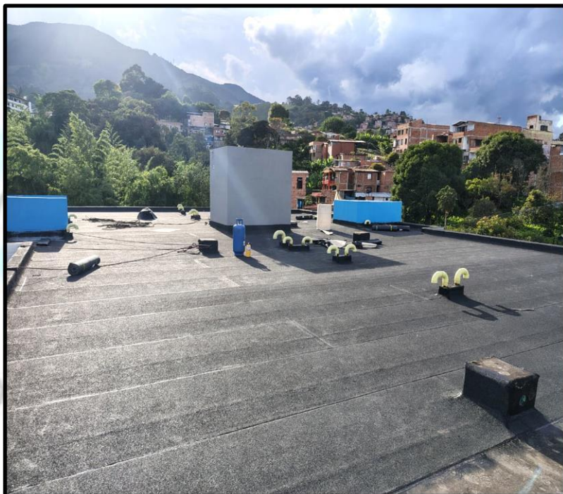
CUBIERTAS CON MANTO IMPERMEABILIZANTE "GRANILLADO"
