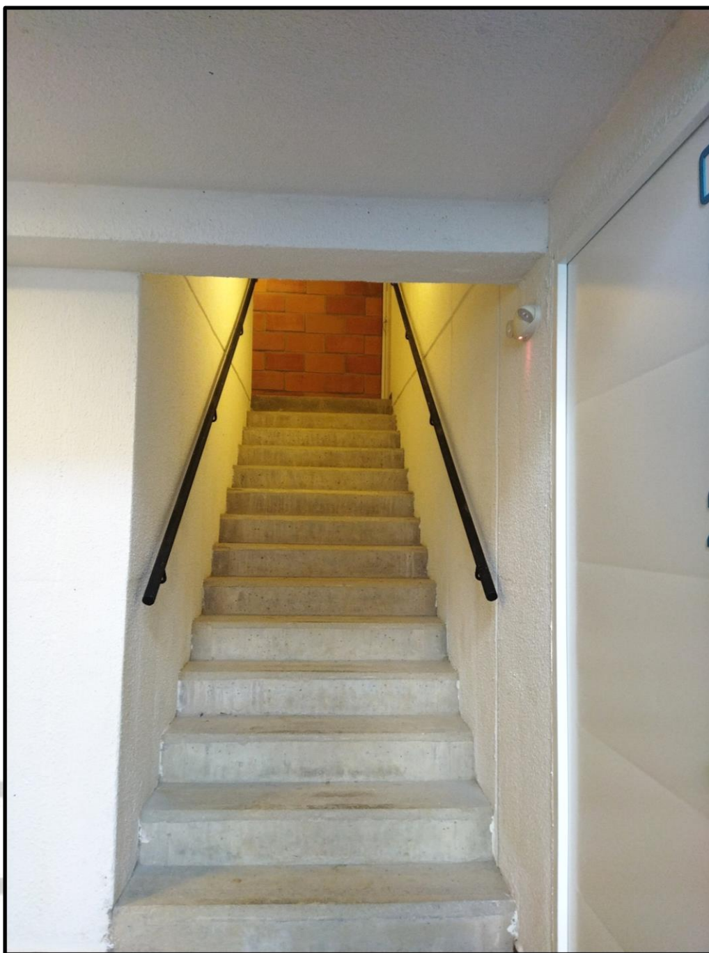
ESCALERAS DE ACCESO PUNTO FIJO PISO 1
