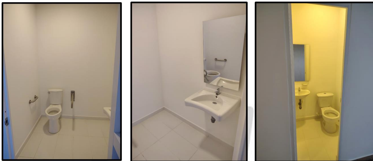
BAÑOS EN EDIFICIO DE ZONAS COMUNES
