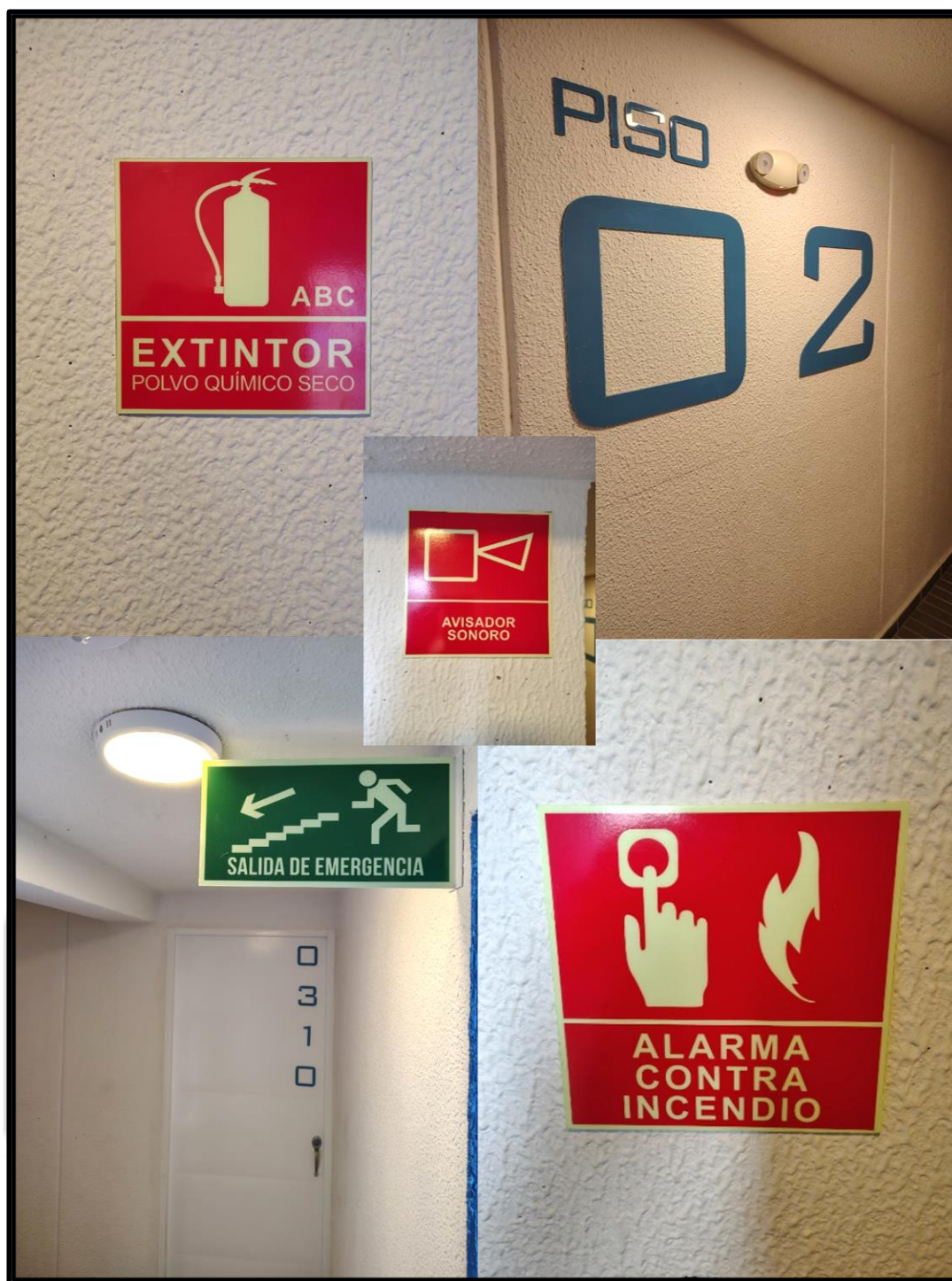
SEÑALIZACION EN PUNTOS FIJOS
