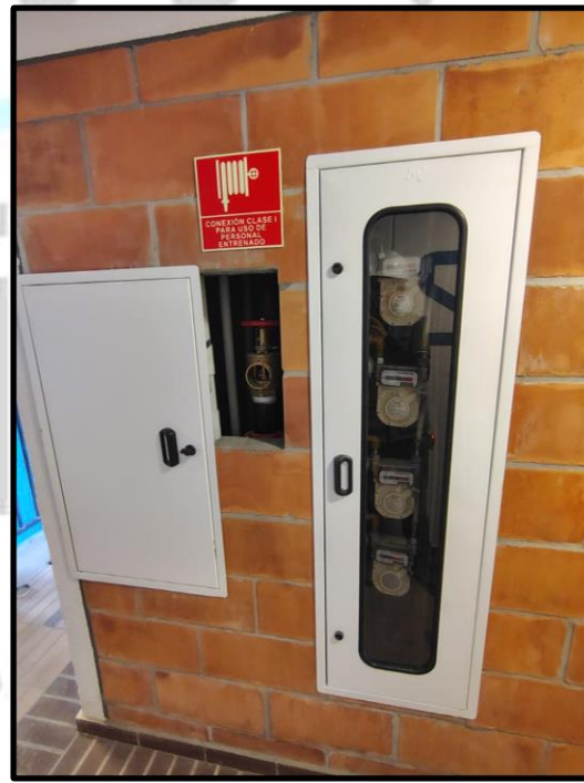
GABINETE DE TELECOMUNICACIONES, GAS Y ACUEDUCTO EN PUNTOS FIJOS
