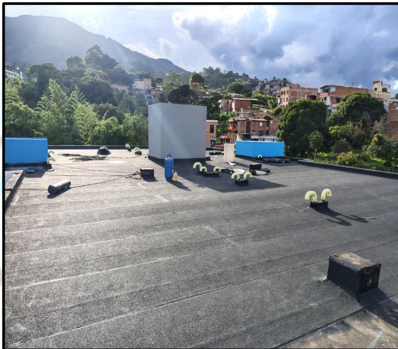
CUBIERTAS CON MANTO IMPERMEABILIZANTE “GRANILLADO”
