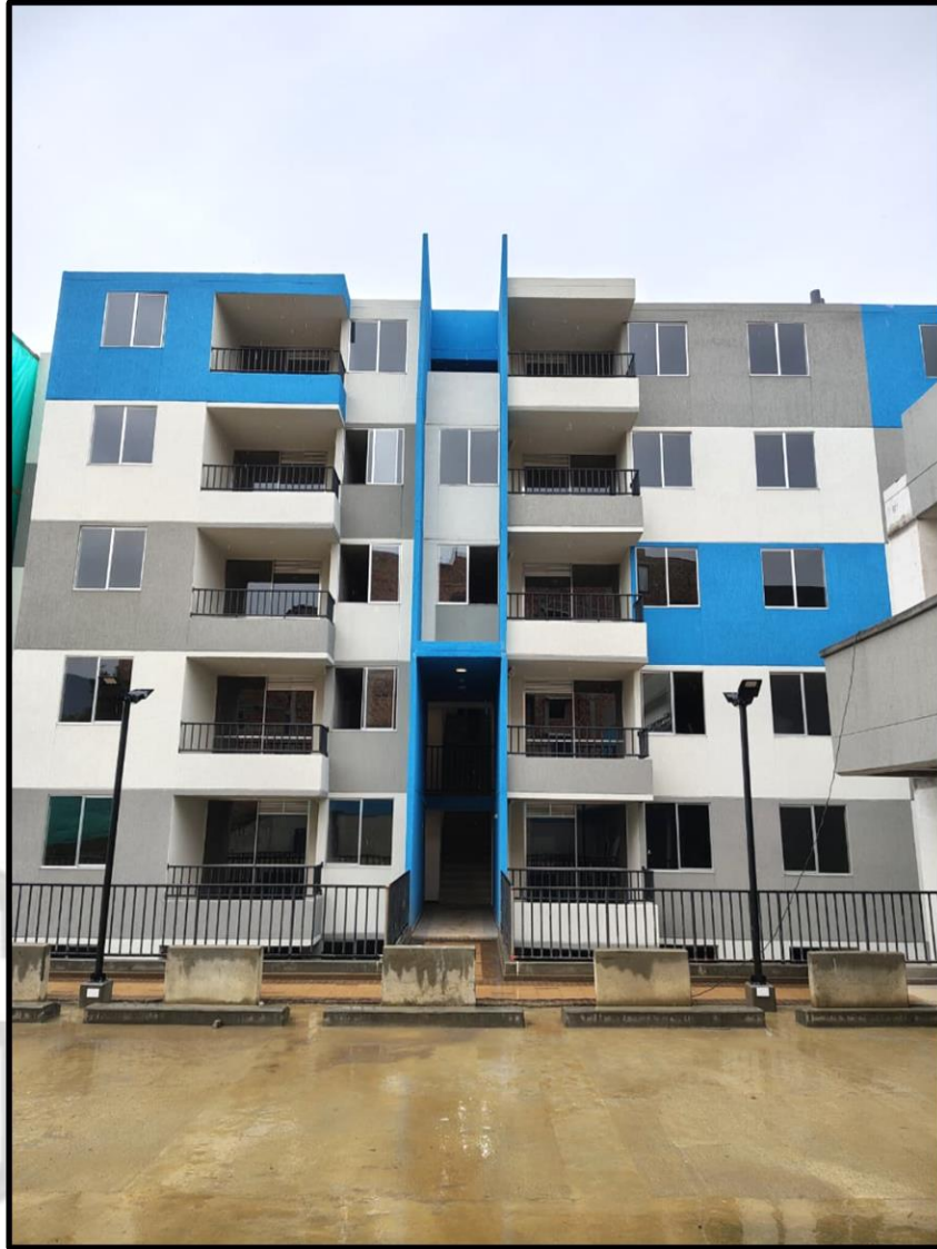
ACCESO A TORRE 3 BLOQUE A
