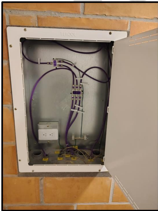
GABINETE DE TELECOMUNICACIONES, GAS Y ACUEDUCTO EN PUNTOS FIJOS
