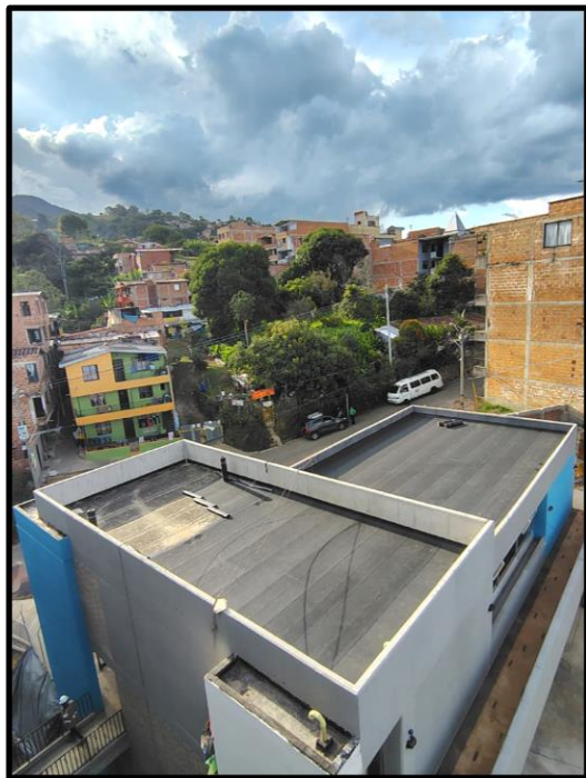
CUBIERTAS CON MANTO IMPERMEABILIZANTE “GRANILLADO”
