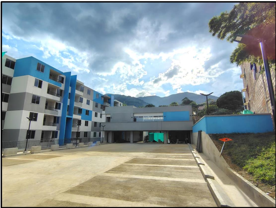
PLATAFORMA DE PARQUEADERO VEHICULAR
