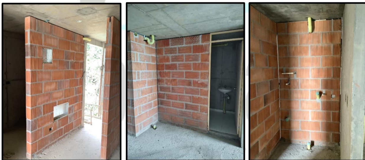
BUITRONES Y MUROS EN MAMPOSTERÍA EN EL INTERIOR DE LOS APARTAMENTOS
