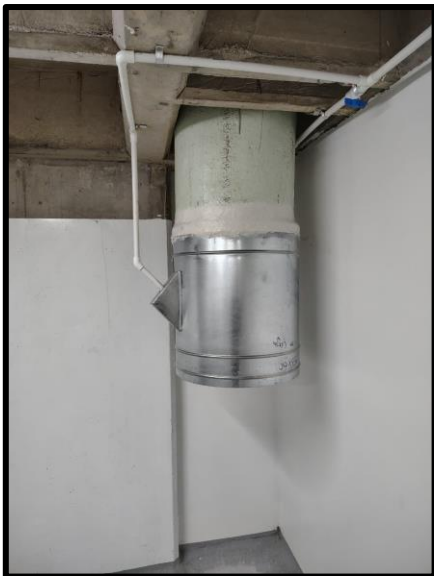
DUCTO, ROCIADOR Y COMPUERTAS
